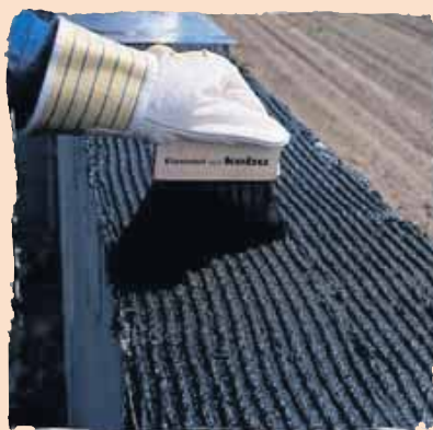
KEBU ELASTOBIT se nanáší pomocí drážkované (zubaté) špachtle celoplošně a rovnoměrně. Drážky se musí mít stejný směr.
