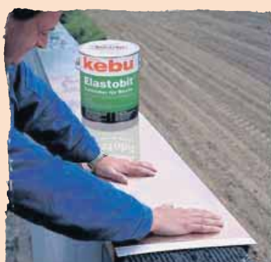
Plech rovnoměrně přitlačíme na pevnou plochu.
