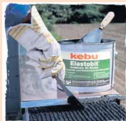
Při spojování plechů je nutné provést dilataci tím, že spoje podložíte 10 cm širokým páskem.
